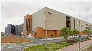
Imagen: Hospital General de Fuerteventura (HGF)
